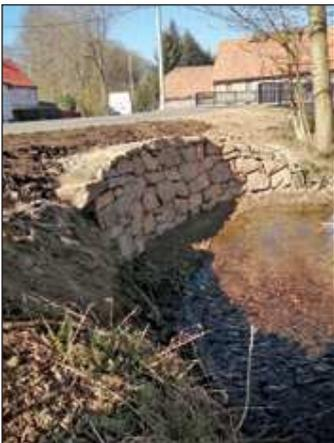
Bei einem Teilstück des Schweikershainer Bach wurde der natürliche Bachverlauf wiederhergestellt. Rasengitterplatten wurden entfernt und zur Böschungssicherung Schwarzerlen
